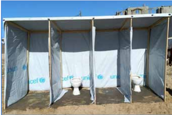
Im Aufbau: einige WC-Zellen; Foto: Clean Shelter
